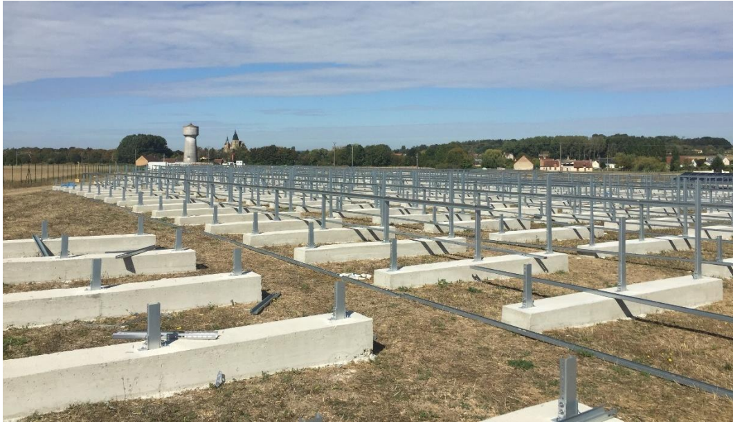
Installation des structures photovoltaïques sur les longrines bétons
